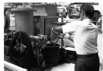
◆スラッジタンクからスラッジを回収する作業
